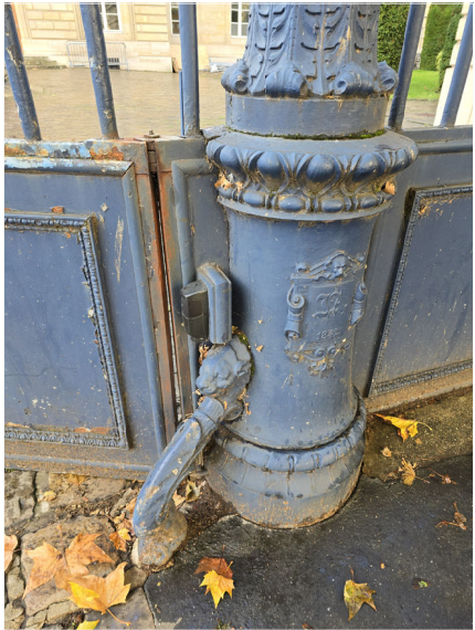
Socle du candélabre et chasse roues (côté boulevard des Invalides)
