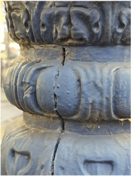
Détail du socle du candélabre (possibilité d'ouverture)
