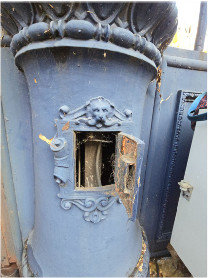
Socle de candélabre creux et réseaux
