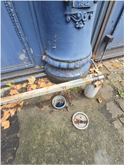
Réseaux en pied de socle et bras "opérateur"
